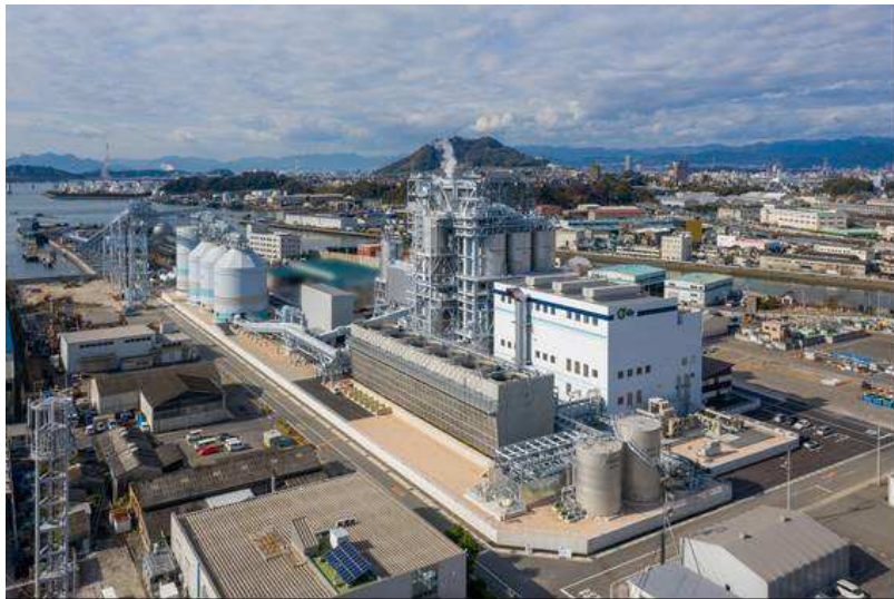
《海田発電所外観》
